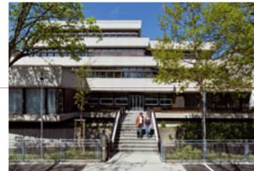
Die IHK Nordschwarzwald hat sich für eine internetgestützte Backuplösung entschieden.
